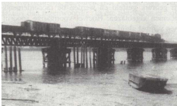
De "Victory Bridge" tussen Spyck en Welle, april 1945, gefotografeerd vanaf de zuidelijke Rijnsoever door Sergeant Harry W. Sibson (934th Port Construction & Repair Company, Royal Engineers) Met dank aan Malcolm H. Sibson.
