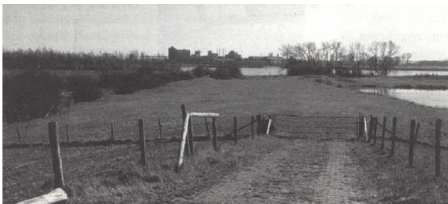
Welle; gezicht vanaf de noordelijke Rijndijk op de plek van het voormalige spoortracé van de Trajektlinie. Rechts van het midden, waar nu de bomen staan, moet de "Victory Bridge" hebben gelegen. Tussen het struikgewas vindt men nog allerlei vaagheden die hiermee van doen zouden kunnen hebben, alsook van de aanlegplaats van het spoorveer. Op de achtergrond de olieraffinaderij te Spyck (foto: V. M. Lansink, 23 maart 2003).
