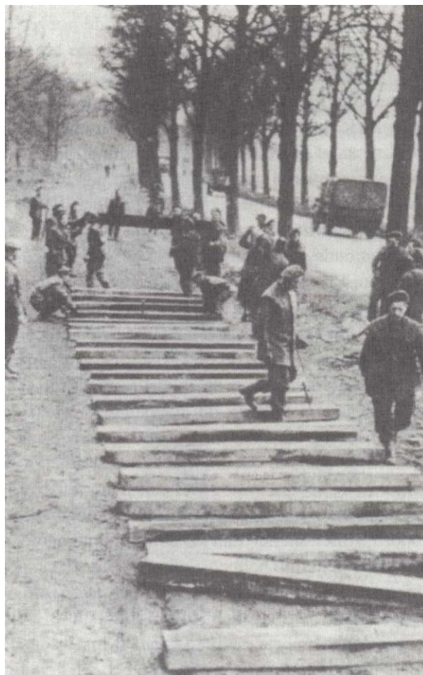
De Engelse genie legt tussen Mook en Plasmolen op het fietspad aan de boskant een spoorlijn aan (foto uit: "In Swaeren Noodt", 1994, p 194).
