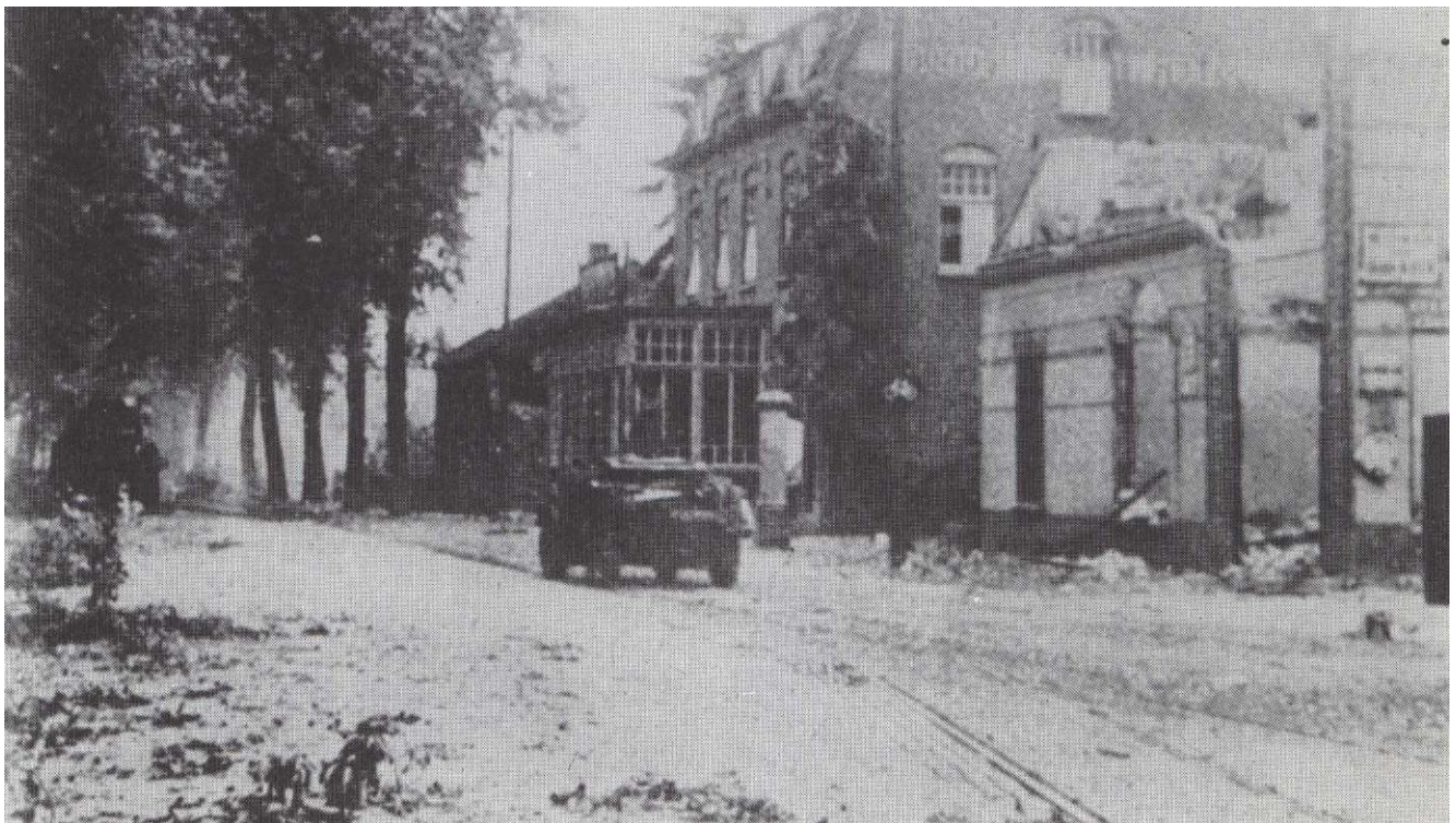
De verwoeste bakkerij van Dinnissen, naast het nog bijna onbeschadigde Hotel van Hendriks. Geheel links is nog juist de uitgeschakelde Sherman-tank zichtbaar (foto N.A. de Groot)
